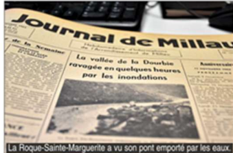
La Roque-Sainte-Marguerite à vu son pont emporté par les eaux.
