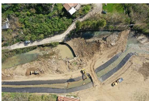
Phase 1 : Démolition de la chaussée (avril 2023)
