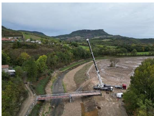
Mise en place de la passerelle (3 novembre 2023)
