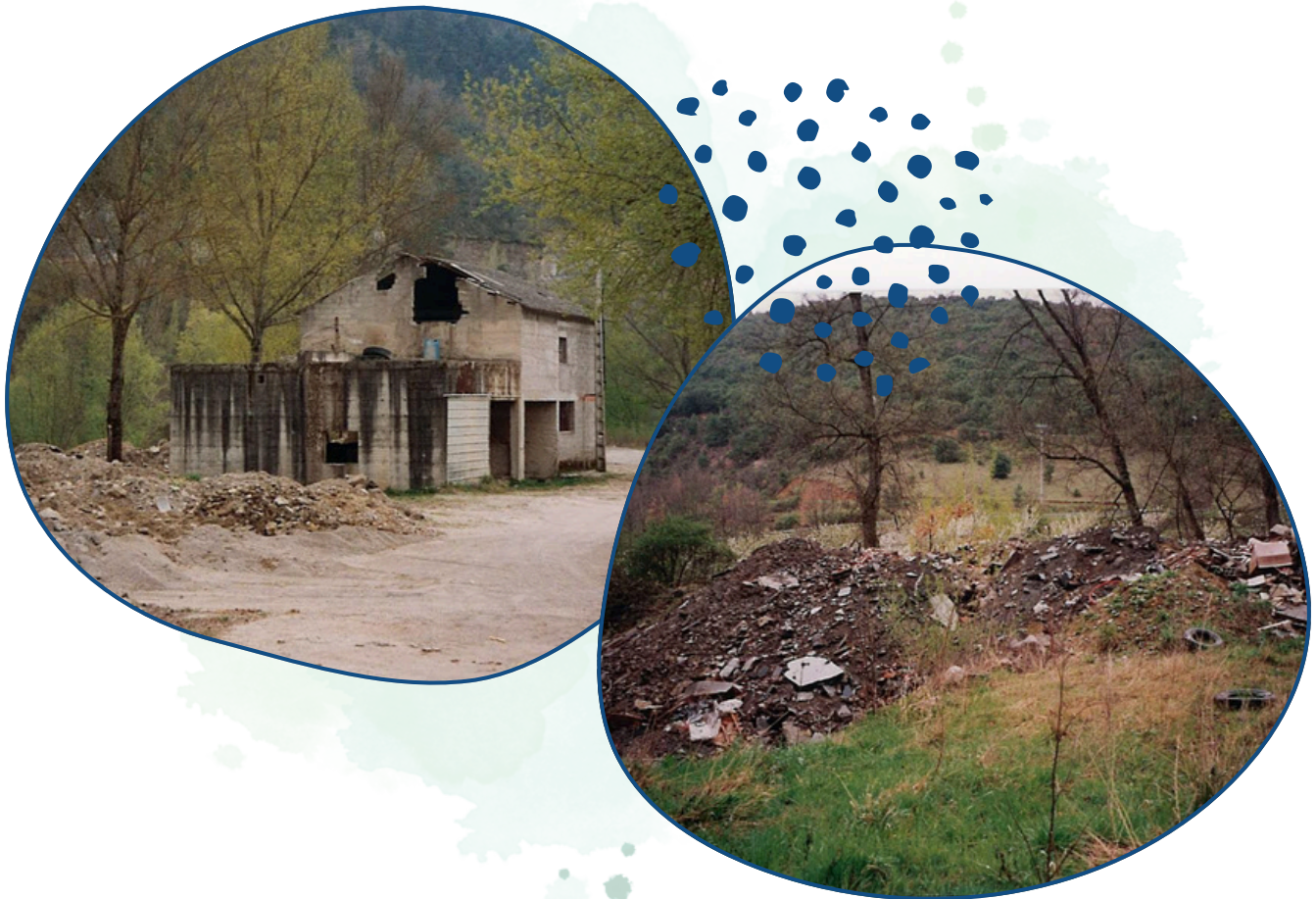
Bâtiment de la Sablière en 1994 (à gauche) et décharge sur les rives de la Sablière en 1994 (à droite) (© Conseil départemental de l'Aveyron)
