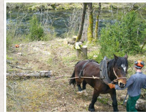
Travaux en rivière
