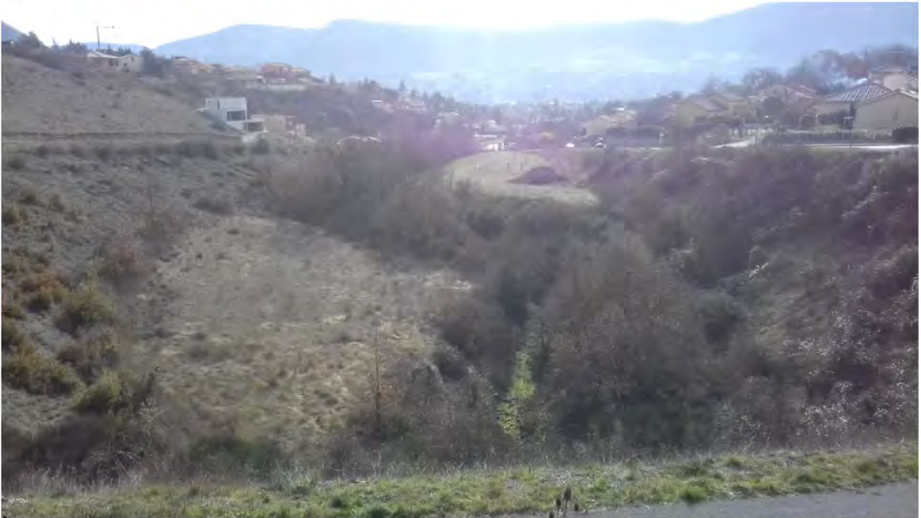
Bassin versant du Ladoux débouchant sur la première zone urbanisée, sur les hauteurs de Millau
