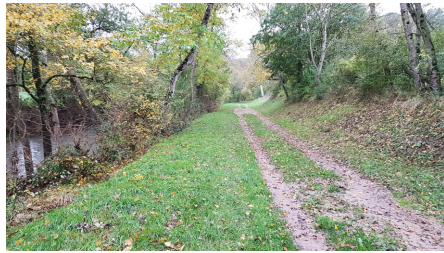
△ En rive gauche, le chemin carrossable se termine en impasse en rive droite se termine en impasse
