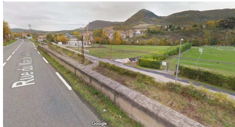
△ Aperçus du site et du village depuis l'entrée de ville depuis la RD992 / source : google maps
