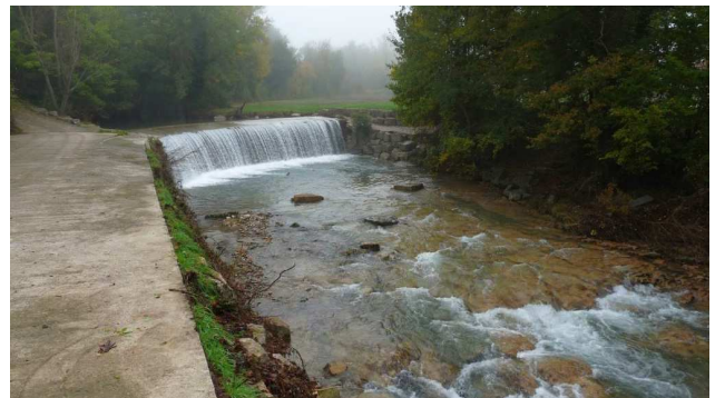
Figure 13 : Secteur en aval immédiat du seuil avec des affleurements de roche mère bien visible.
