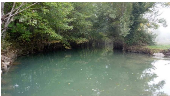
Figure 12 : Illustration de la retenue en amont du seuil haut avec des écoulements lents typiques et un tracé plutôt rectiligne.
