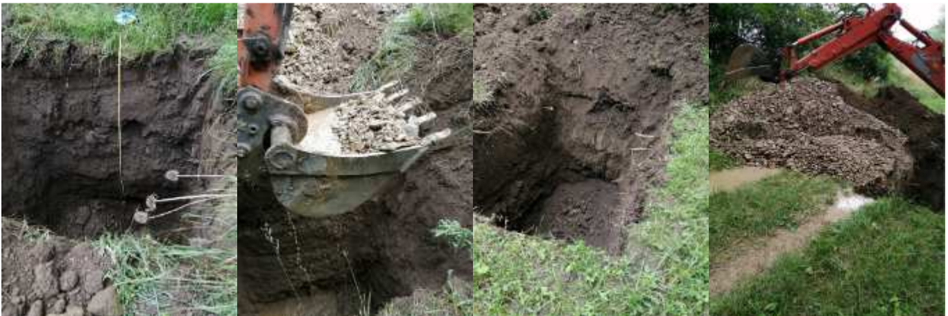
FIGURE 4 : PHOTOS DES SONDAGES S1 LIMITE AMONT ET S2
