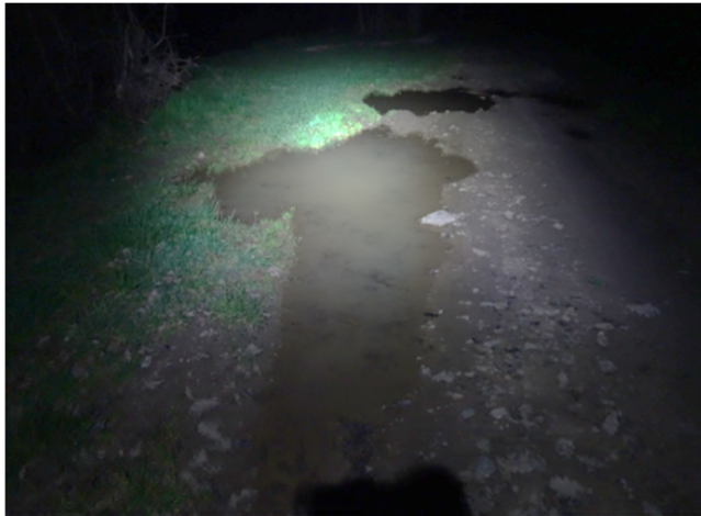
Ci-dessous, vue sur une ornière du chemin en rive gauche du Cernon – point d'inventaire N°4.
