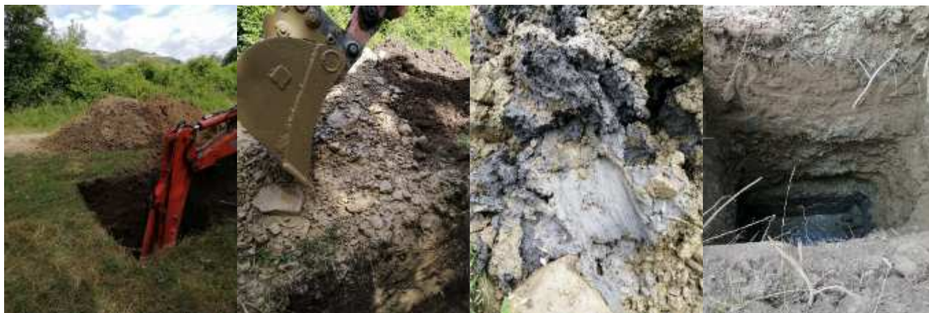
FIGURE 5 : PHOTOS DES SONDAGES S3 ET S4
