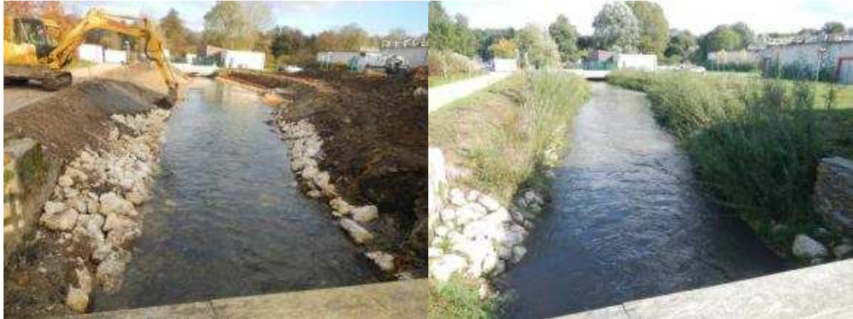
FIGURE 28 : EXEMPLES DE SEUILS DE FOND EN BLOCS MIS EN ŒUVRE DANS LE CADRE D'UNE OPERATION DE RESTAURATION DE TRONÇONS DE RIVIERE (SOURCE EGIS)
