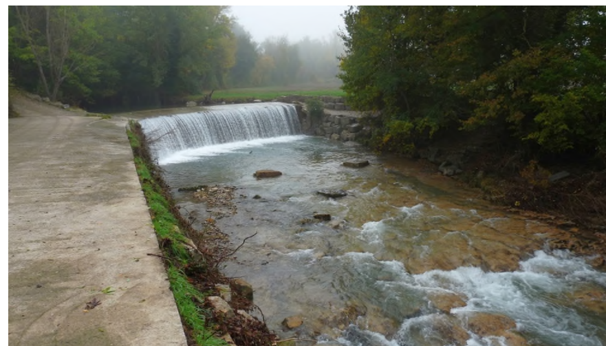
Figure 9 : Secteur en aval immédiat du seuil avec des affleurements de roche mère bien visible.
