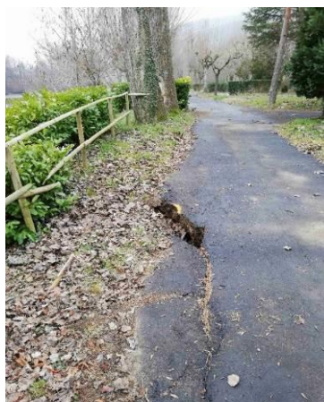
Voirie en bordure du Tarn avant travaux
