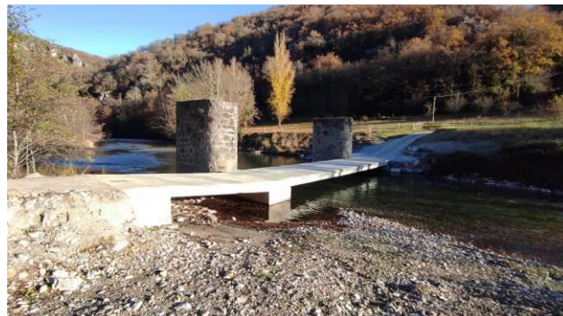
Passage submersible après travaux
