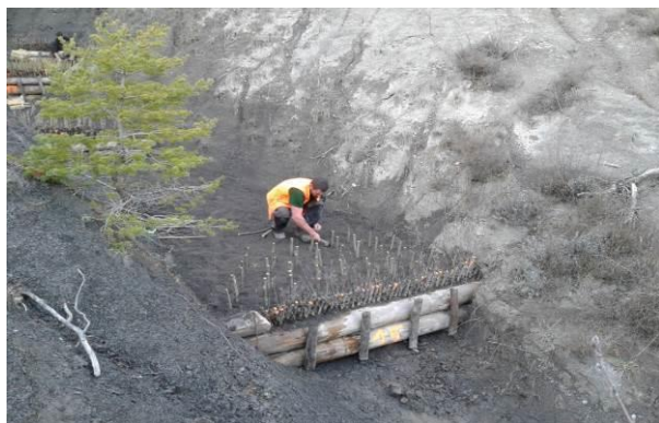
Bouturage de saule dans le lit de la ravine
