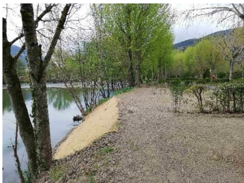
Berge protégée après travaux
