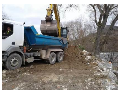
Evacuation des remblais et des enrochements
