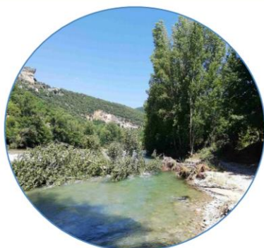
Travaux de gestion de la végétation des berges
