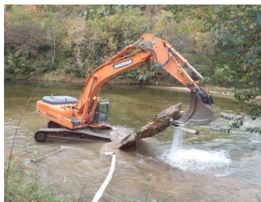
Intervention d'une pelleteuse pour retrait de la conduite
