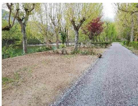
Voirie déplacée et emplacements de camping réaménagés après travaux
