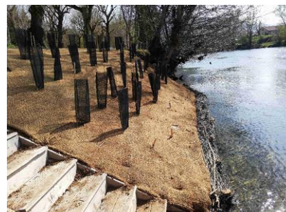
Stabilisation d'une berge de camping en génie végétal
