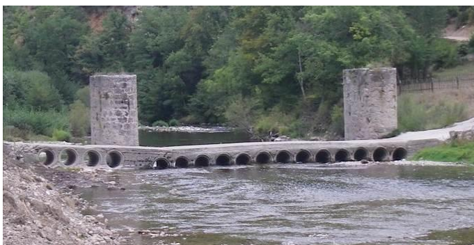
Passage submersible avant travaux
