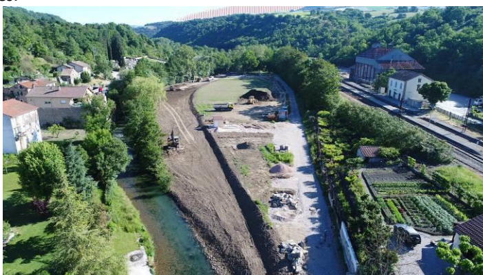
Travaux de la ZEC de Saint-Rome-de-Cernon
