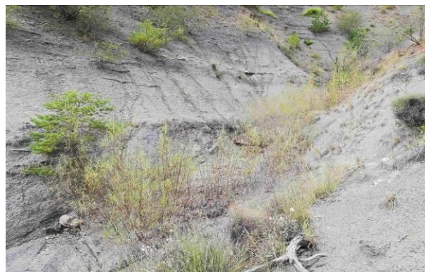
Lit de la ravine 1an après travaux
