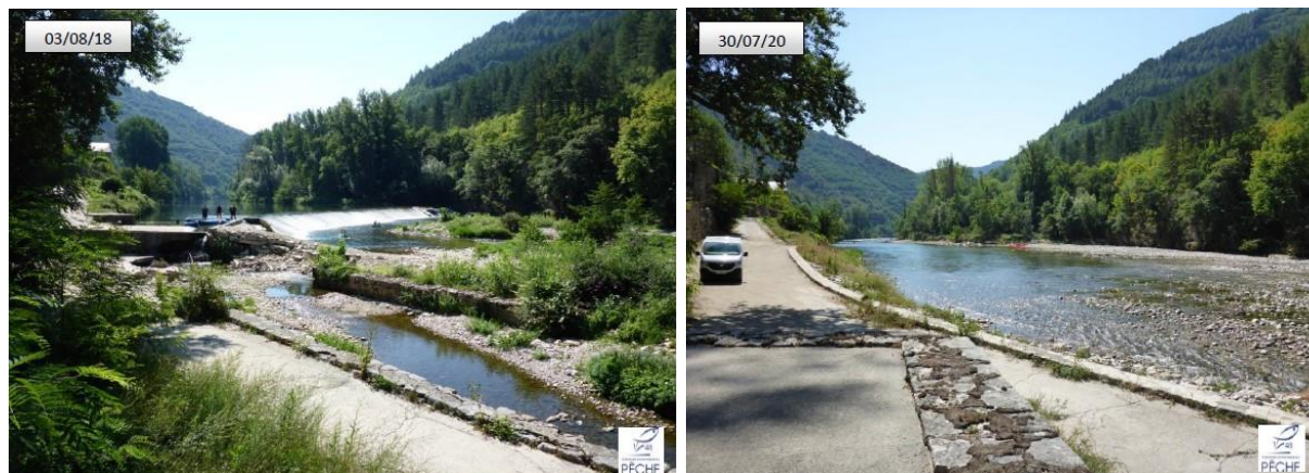
Crédit photo Valérie PROUHA FDP 48 : Photos avant et après travaux d'effacement du seuil de Prades
