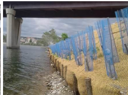
Stabilisation de la berge en génie végétale
