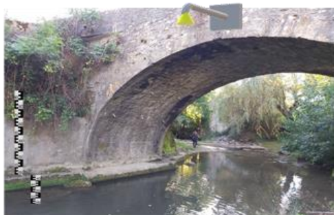
Lopanouse de Cernon, station limnimétrique : radar
